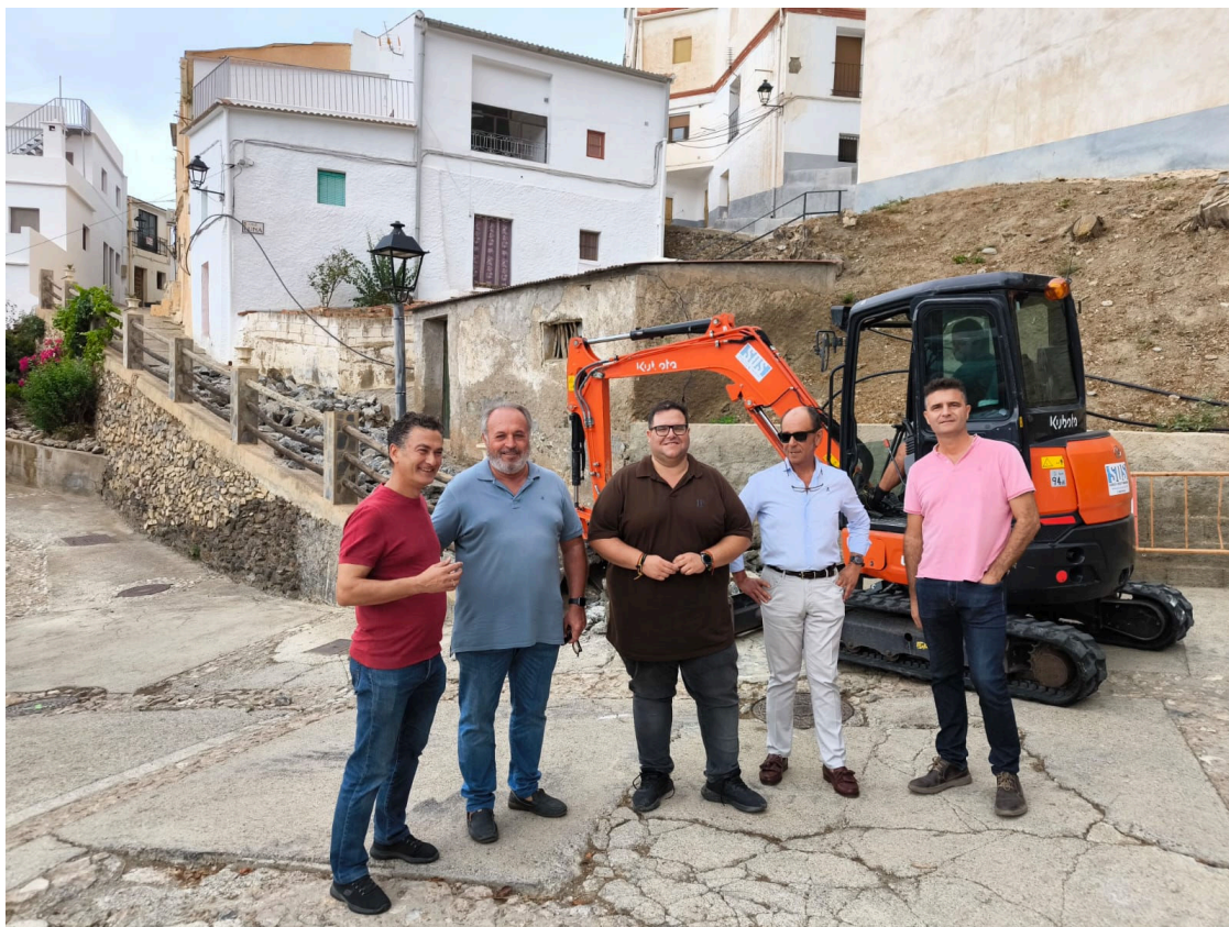
Visita a las obras en Polopos | Foto: Gabinete
